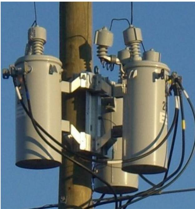
**Figura 3.** Dispositivo de Protección de Fauna tipo cubierta en el sistema de energía en Duke Power.
