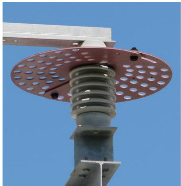
**Figura 9** DPF de tipo barrera montado demasiado cerca de la zona de alta tensión.
