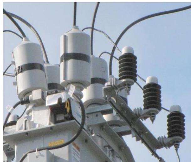
**Figura 2.** Dispositivo de Protección de la Fauna tipo cobertura en los bujes de un reconector y
