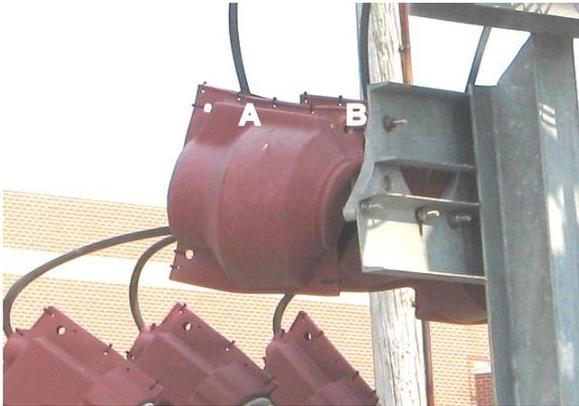
**Figura 7.** Supresor de cubierta grande con una mala gestión de cables.
